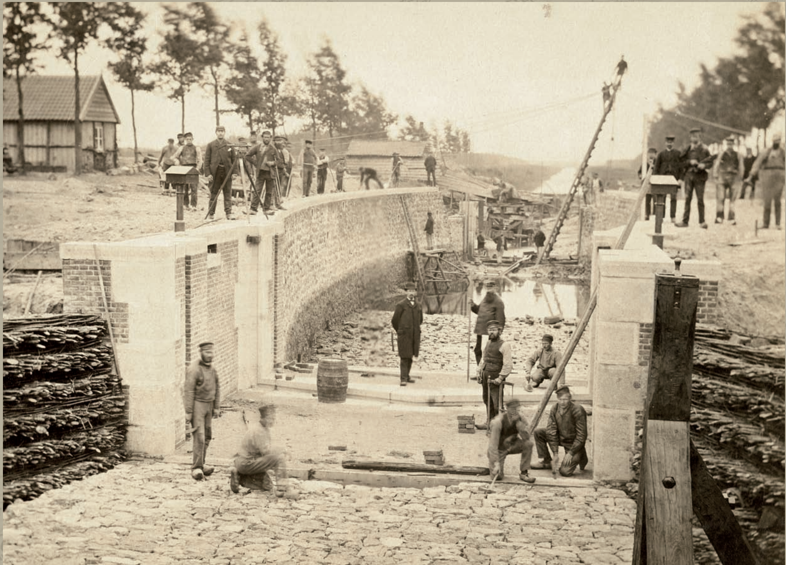
Unieke opname van de aanleg van het sluisje in het Afwateringskanaal onder Meijel. Datum: oktober 1884. Wie zouden toch die bouwvakkers zijn?
